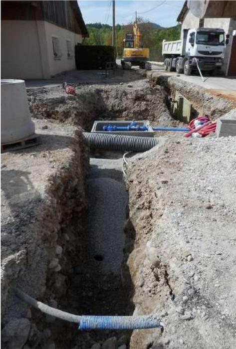
Dans le cadre de son programme de renouvellement des conduites d'eau potable, la communauté de communes de Yenne a réalisé une première tranche de travaux et de mise en conformité des branchements au hameau d'Ameysin à Yenne.
